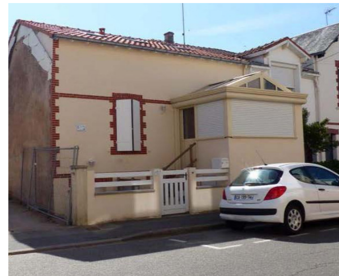
Des extensions qui masquent la façade principale et sont sans rapport avec la construction existante
