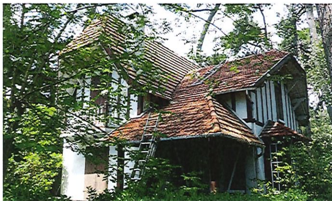
Toiture complexe en tuile mécanique
