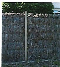
Brande toute hauteur sur poteaux bois
