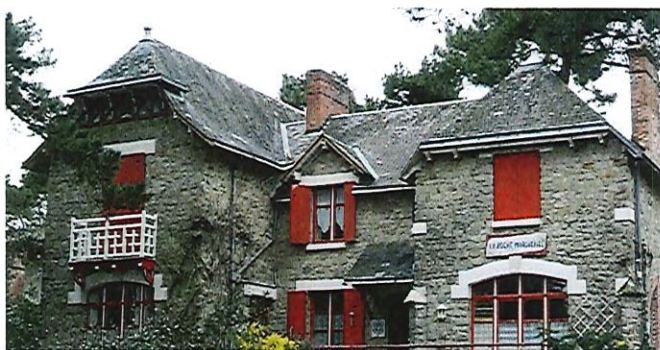
Toiture complexe en ardoise
