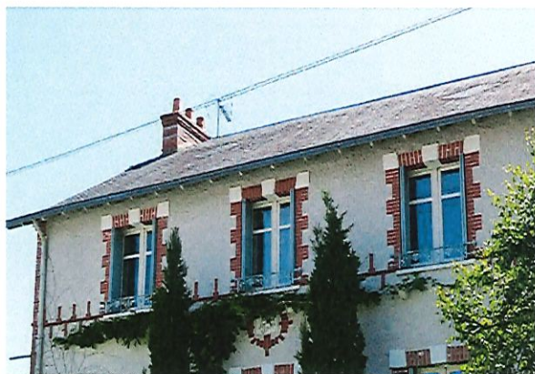
Toiture traditionnelle en ardoises
