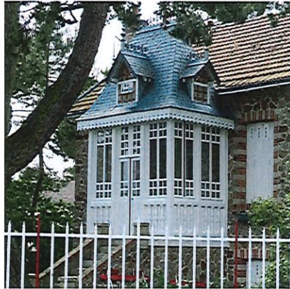
Perron sous forme de bow-window
