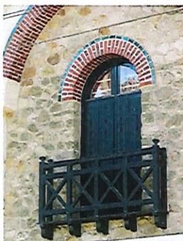
Encadrements de baies en brique
