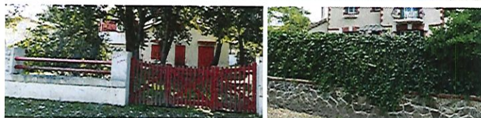
Murets surmontés de dispositifs à claire-voies (en harmonie avec la construction)
