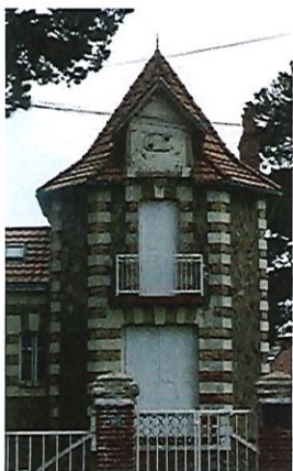
Chaînage d'angle et encadrement brique et pierre
