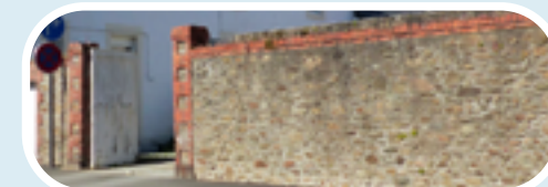
Mur en pierre
