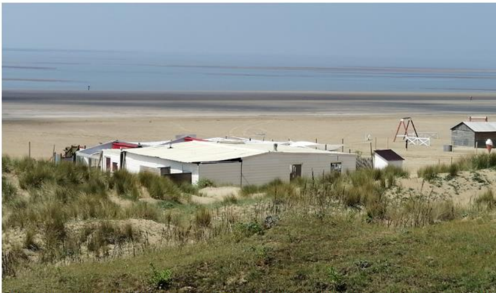
le site en saison depuis la dune. Les façades arrière et latérales de même que la toiture sont des éléments très visibles du fait de l'accès à la plage par les dunes qui surplombent les constructions.
